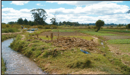
Irrigation system in Tanzania © Els Lecoutere
