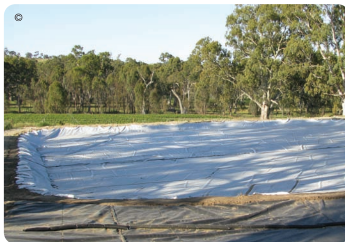
La copertura VapourGuard installata da Fabtech
